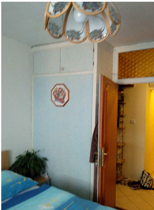
3. Odstraneni vestavenych skrin stareho typu (drevena konstrukce), 360x50x250cm a 120x60x250
